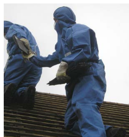
Enlèvement manuel d'ardoises amiantées par traitements simples
