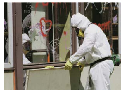
Désamianteurs professionnels au travail
