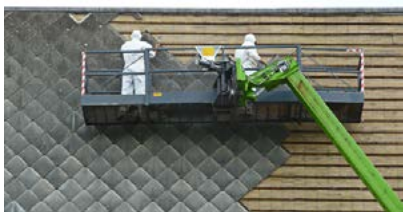
Equipements de travail adaptés pour le désamiantage en hauteur
