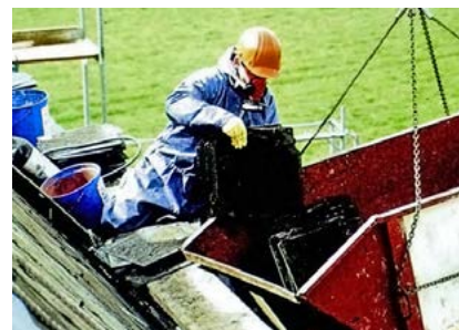
Utilisation d'une benne pour faciliter l'évacuation
