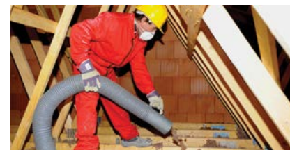
Soufflage de laine de roche en combles perdus
