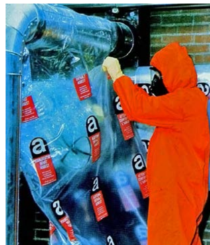
Utilisation d'un sac à manchon
