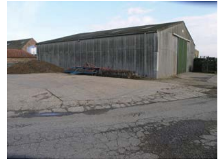
Plaques ondulées amiantées en bardage et toiture
