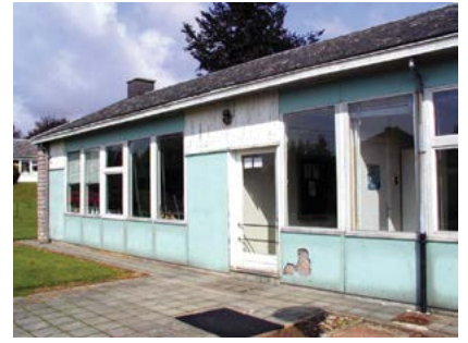
Schoolgebouw van het type RTG
