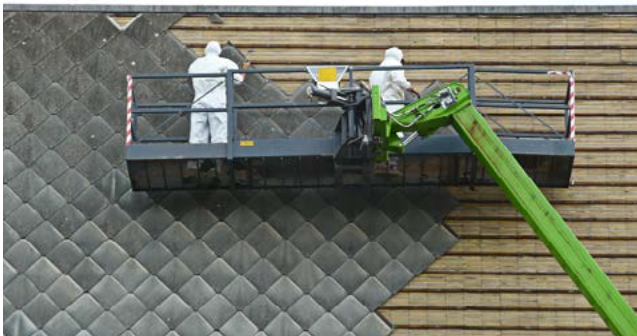
Aangepaste arbeidsmiddelen voor asbestverwijdering op hoogte
