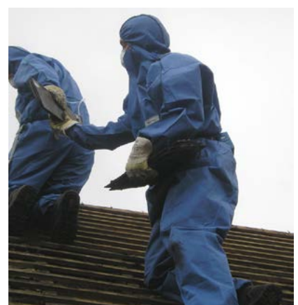
Asbesthoudende leien handmatig verwijderen als 'eenvoudige handeling'
