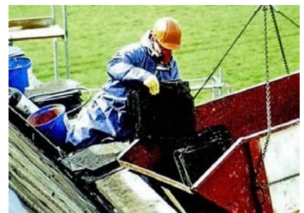
Gebruik van een bak om asbest makkelijk te verwijderen
