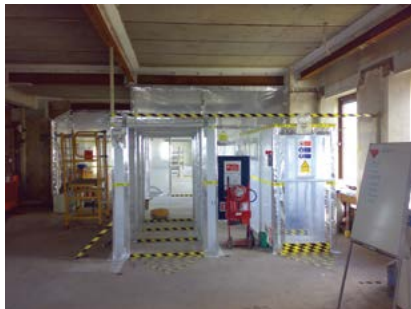
Toegangssluis naar de afgesloten zone
