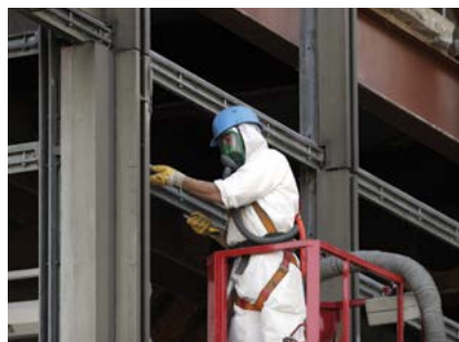
Een brandvertragende plaat op hoogte verwijderen vanuit een werkbak
