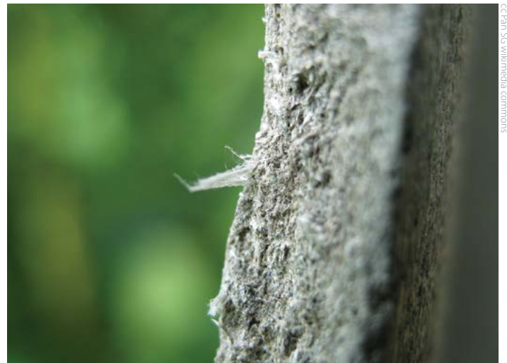
Gebonden asbestvezels in cementmatrix
