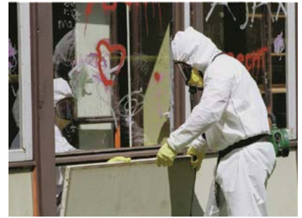
Professionele asbestverwijderaars aan het werk
